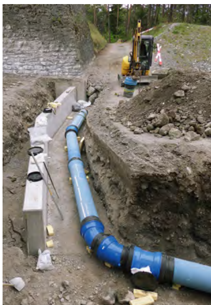
Leitungsführung durch ein Flussbett: Gussrohre mit Faserzementmörtel-Umhüllung und Formstücke von Hagenbucher . Mit der bewährten BLS-Verbindung sind Richtungsänderungen kein Problem.
