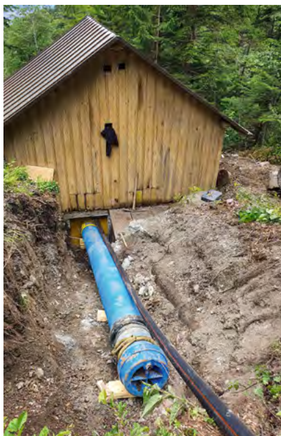
Die neue Druckleitung wird durch das alte Rohrbruchklappengebäude geführt.
